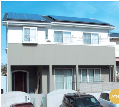
2階の増築のため耐震工事、屋根の総替え。太陽光発電の容量アップ。照明はLED。
